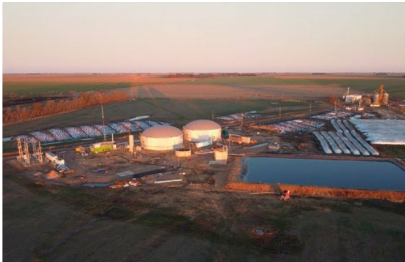
Vista aérea de la planta.
