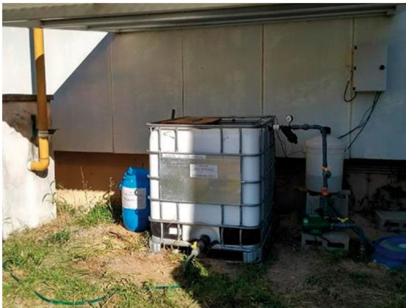
El sistema diseñado permitió tratar aguas residuales con alta concentración de fitosanitarios hasta alcanzar una remoción completa de glifosato, AMPA, atrazina, carbendazim y prometrina.
