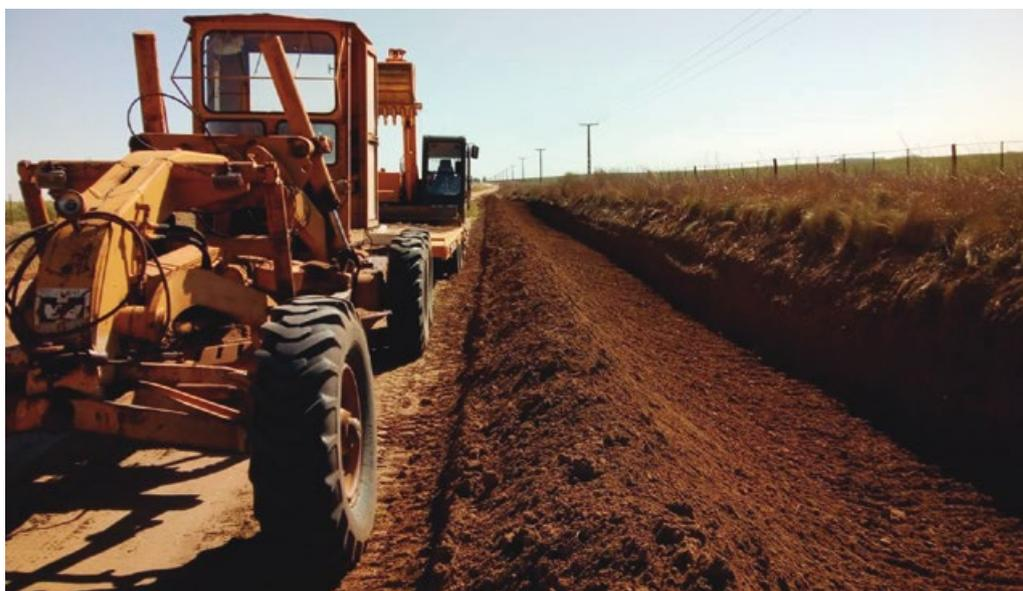
En los bajos con potencial de anegamiento se realizan reservorios para derivar excesos hídricos y asegurar la transitabilidad durante períodos de lluvias torrenciales.
